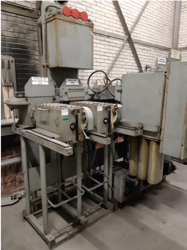
② 10 KV lastschakelaar compressor koppeling met O.S. haven
